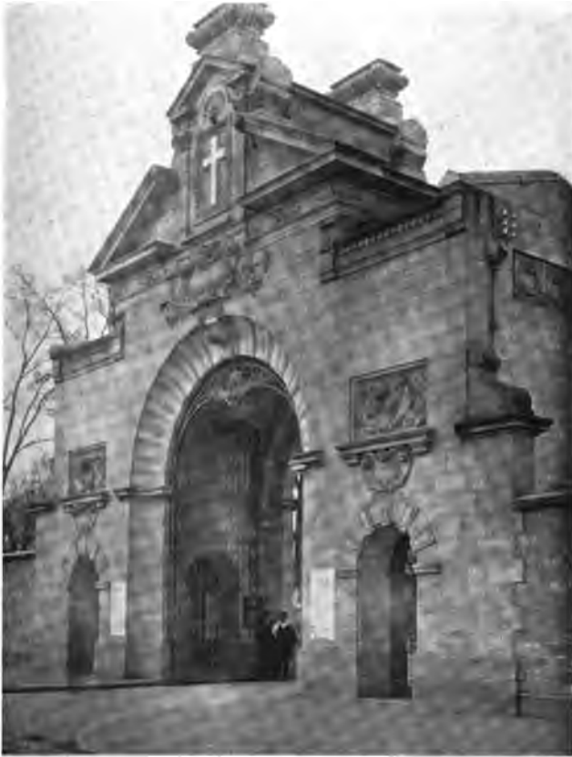
Fig. 71. — Portail moderne en pierre à l'entrée du Grand cimetière des Chartreux de Bordeaux (Œuvre de L. Magne).
